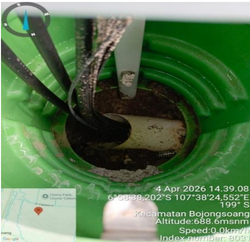
Gambar 5. Pemasangan Pipa HDPE
